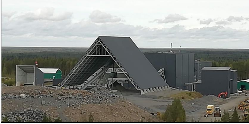
Kuva 1: Vasemmalta oikealle, murska josta kuljetin välivarastolle ja takana on rikastamo rakennus.
